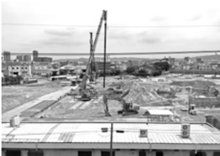
工事現場(日本ペイント寝屋川事業所跡地)
