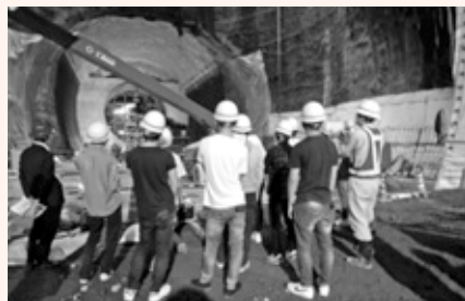
天ヶ瀬ダム再開発事業放流設備トンネル見学(3年生)
